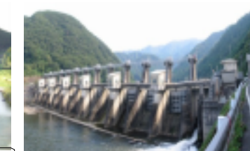
浜原ダム(美郷町) 大きな江の川をせき止めるこのダムは、高さ19m、幅361m、ゲートは全部で12門。このダムができるまでは、源流域までサケが遡上していた。
