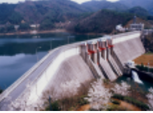
土師ダム(安芸高田市) 1974年に完成した洪水調節などを目的としたダム。総貯水量4730万トン。
